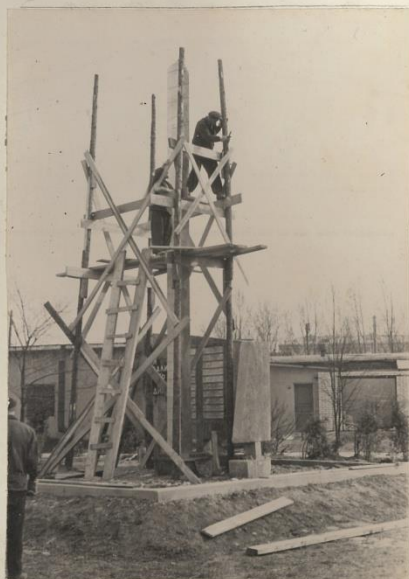
ОБЕЛИСК ВОЗВЕДЕН. МОМЕНТ СНЯТИЯ СТРОИТЕЛЬНЫХ ЛЕСОВ.
