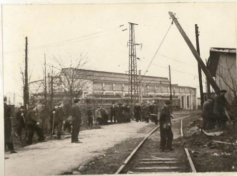
ЗАВЕРШАЮЩИЕСЯ РАБОТЫ ПО БЛАГОУСТРОЙСТВУ ТЕРРИТОРИИ ПЕРЕД ОБЕЛИСКОМ И НА ПОДСТУПАХ К НЕМУ.
